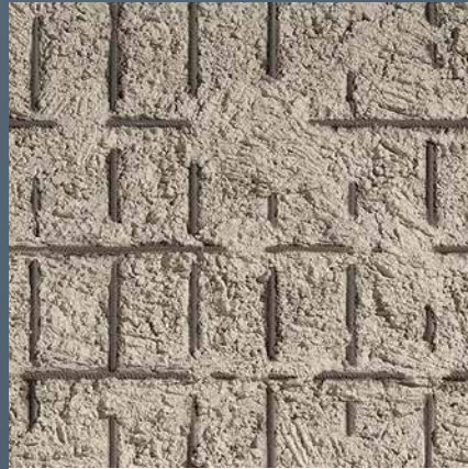
TX-047 Beton Quebrado
